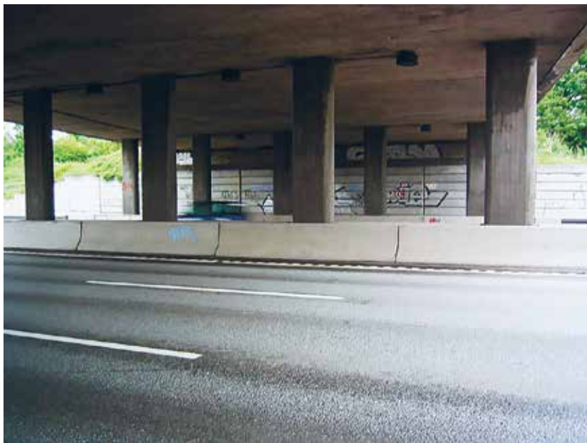
Figur 1: Stivheden og dermed udbøjningen er afgørende for et autoværns evne til at tilbageholde et køretøj. Jo mindre stivhed og jo større udbøjning desto mindre bliver skaderne på både køretøj og personer i køretøjet. Ofte er der ikke plads til, at autoværnet kan udbøjes uden at ramme andre faste genstande bag autoværnet. Her må man anvende et autoværn med en meget større stivhed og dermed en meget mindre udbøjning. Fx anvendes ofte et New Jersey-autoværn som sikring mod at kolliderer med bropiller. Foto fra Håndbog Autoværn med tilhørende udstyr.
