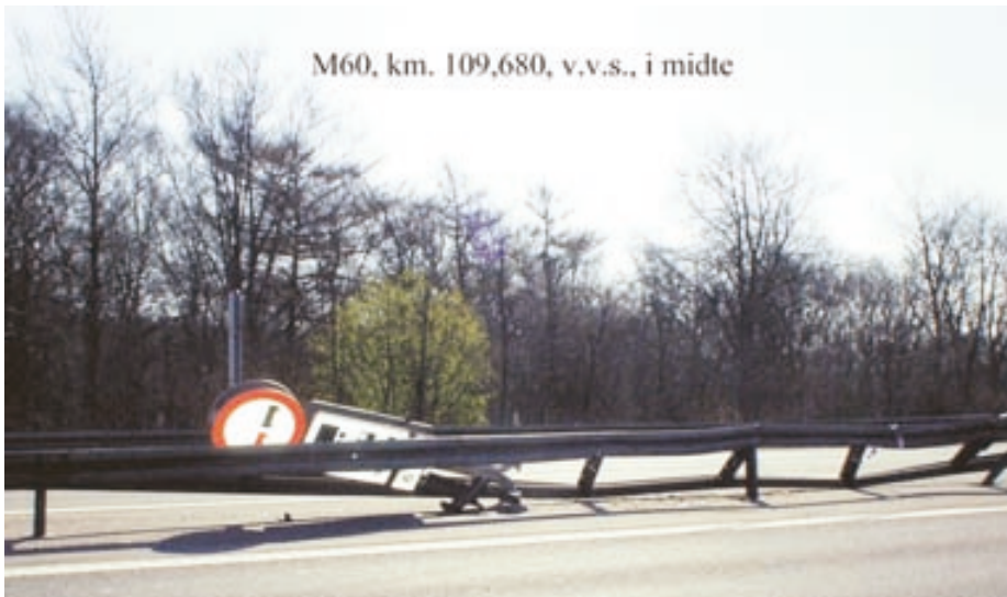
Figur 6. Eksempel på en indirekte påkørt mast placeret imellem et dobbelt midterautoværn.
