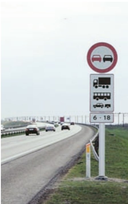
Figur 1. Eftergivelig mast monteret med færdselstavler.
