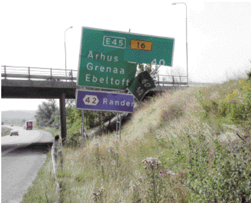
Figur 2. Selv om skilte er placeres bag autoværn, kan de stadig påkøres.
