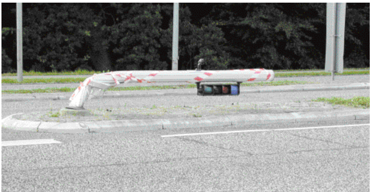
Figur 3. Påkørt signalmast af en eftergivelig type. Havde masten været af en af de "gamle" stålmaster var bilisten ikke sluppet så heldigt fra mødet.
